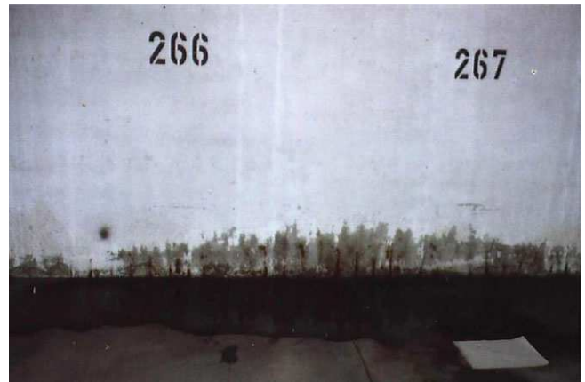
Bild 1 Pfützenbildung entlang einer Stirnwand und Farbabbblätterung am Wandfuß
