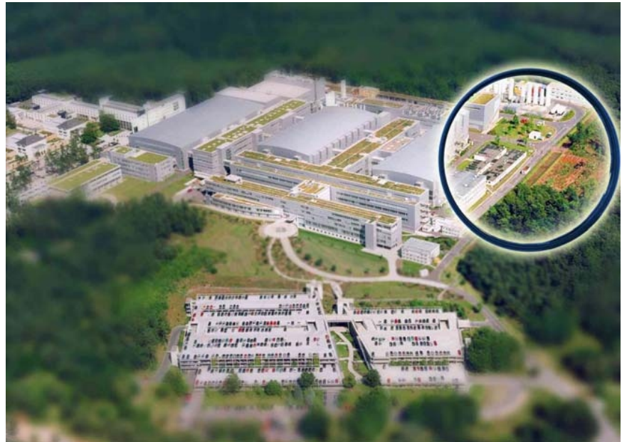
Vogelperspektive - die geplante Betriebsweiterung schließt sich südlich an das Werksgelände an
